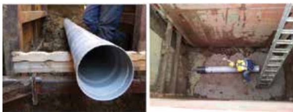
شکل ۵: لوله سلیپ لاین (Segmental Sliplining pipe)
