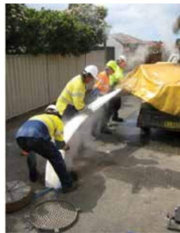
شکل ۴: لوله PVC ناشو و شکل داده شده در طول نصب
